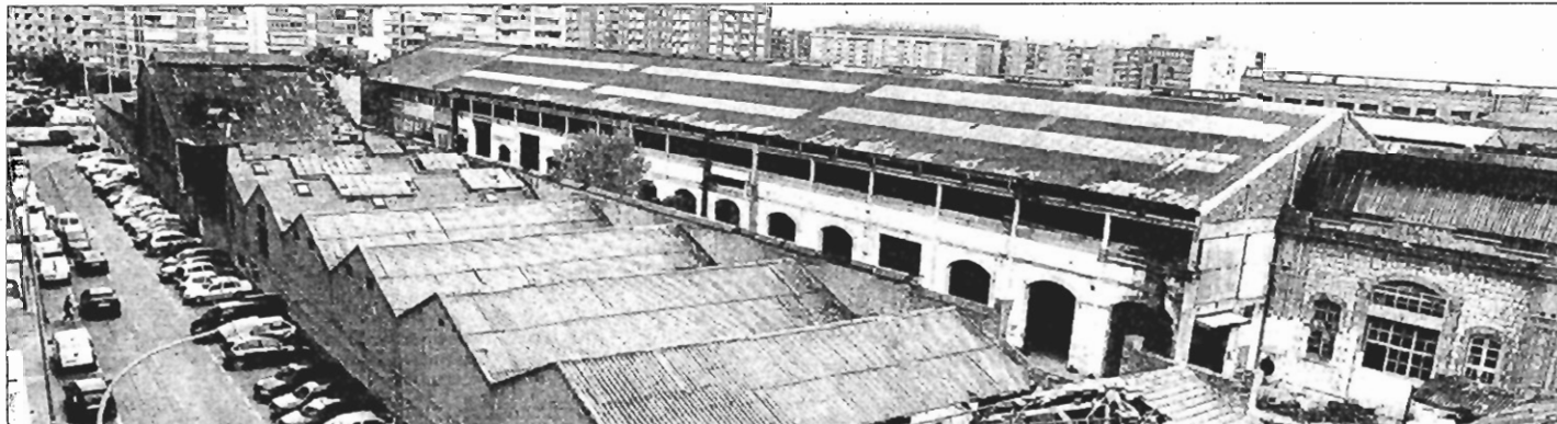
Una de las naves del antiguo complejo industrial de Macosa. /VICENTE MARTÍNEZ
