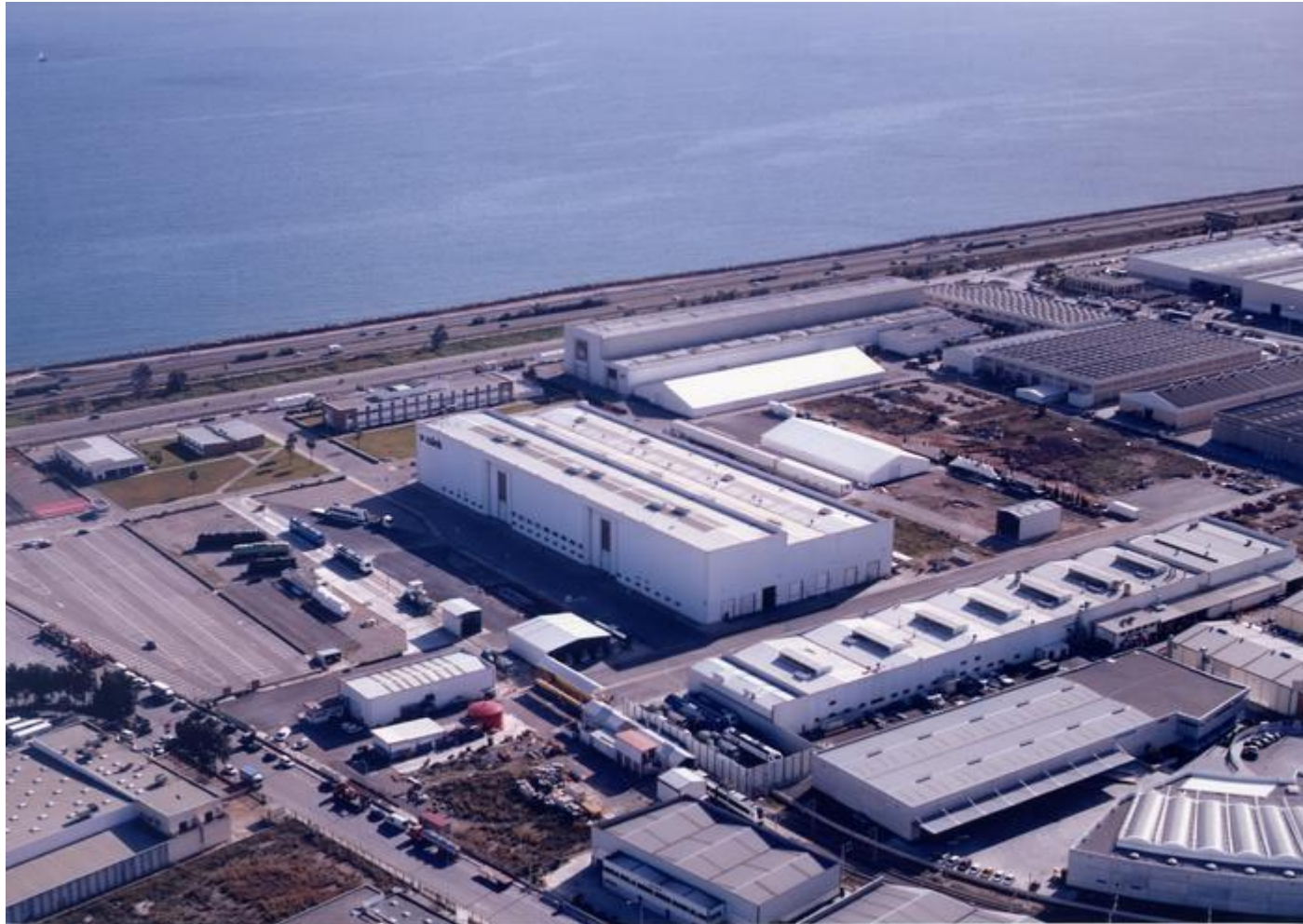
Vista aérea fábrica de Albuixech
